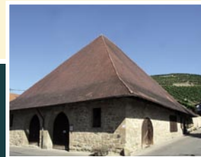
→ Alte Kelter in Kernen-Stetten
