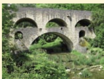
2 Steinerne Doppelbrücke in Rothenburg o. d. T.
